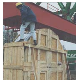
■ Montagem para transporte de sistema completo de Esteira Porta Cabos e cabos
